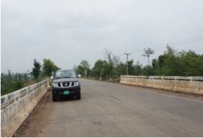
การสำรวจสะพาน
