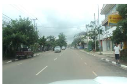
สภาพภายหลังการก่อสร้างแล้วเสร็จ
