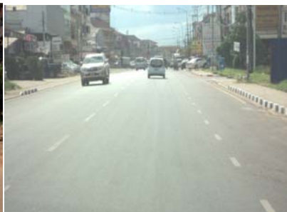
สภาพภายหลังการก่อสร้างแล้วเสร็จ
