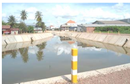
สภาพภายหลังการก่อสร้างแล้วเสร็จ
